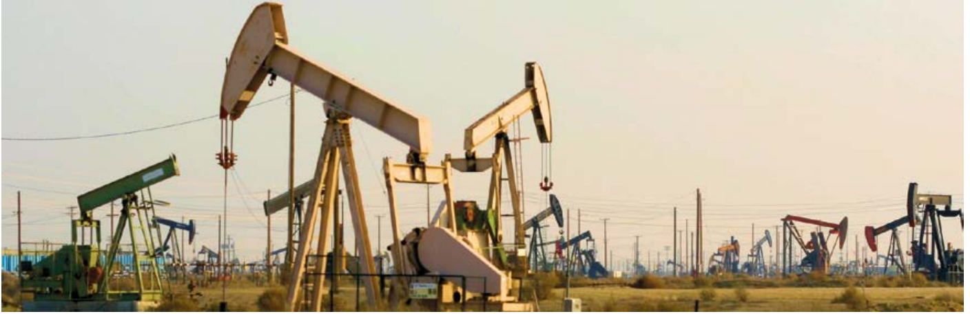
UNE STATION DE POMPAGE TOUS LES 70 À 100 KM...
